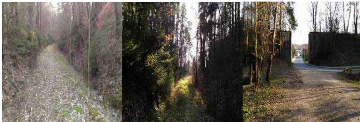
Obrázek 13.20. Zářezy v krajině nad obcí Valcha po demontáži drážního tělesa a bývalé přemostění vlečky na Sulkov (současnost)
