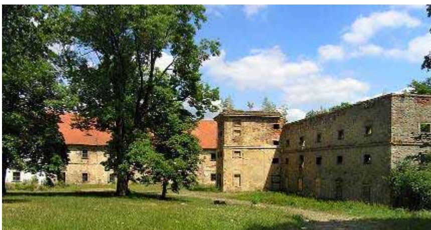
Obrázek 10.9. Neopravené části hospodářského dvora – pivovar a sýpky
