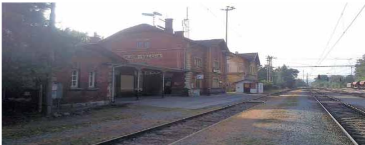
Obrázek 13. 21. Současný stav zemního tělesa dráhy železničního nádraží Plzeň - Valcha
