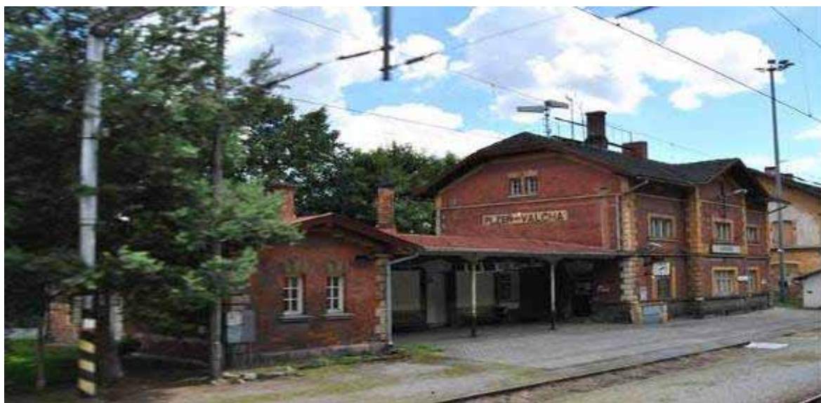
Obrázek 13.29. Propojení lanové dráhy s přilehlou nižší budovou před přístřeškem nádraží
