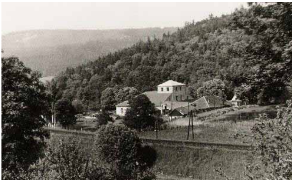
Obrázek 7.8. Pohled na hut' Barbora od zámku
