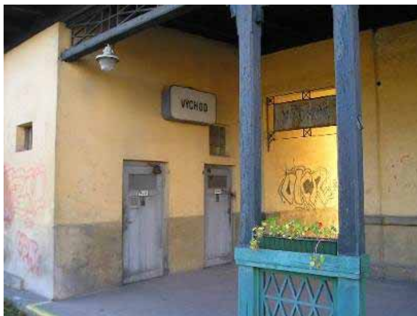
Obrázek 11.5. Pohled do prostor vnitřní strany staniční budovy – pořízeno v roce 2005
