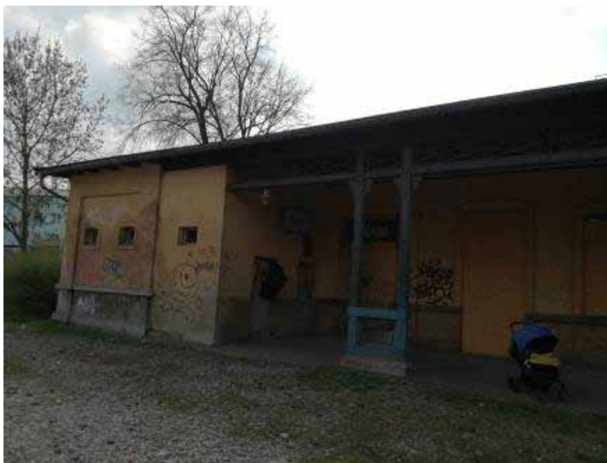
Obrázek 11.8. Pohled do prostor vnitřní strany staniční budovy – pořízeno v roce 2018
