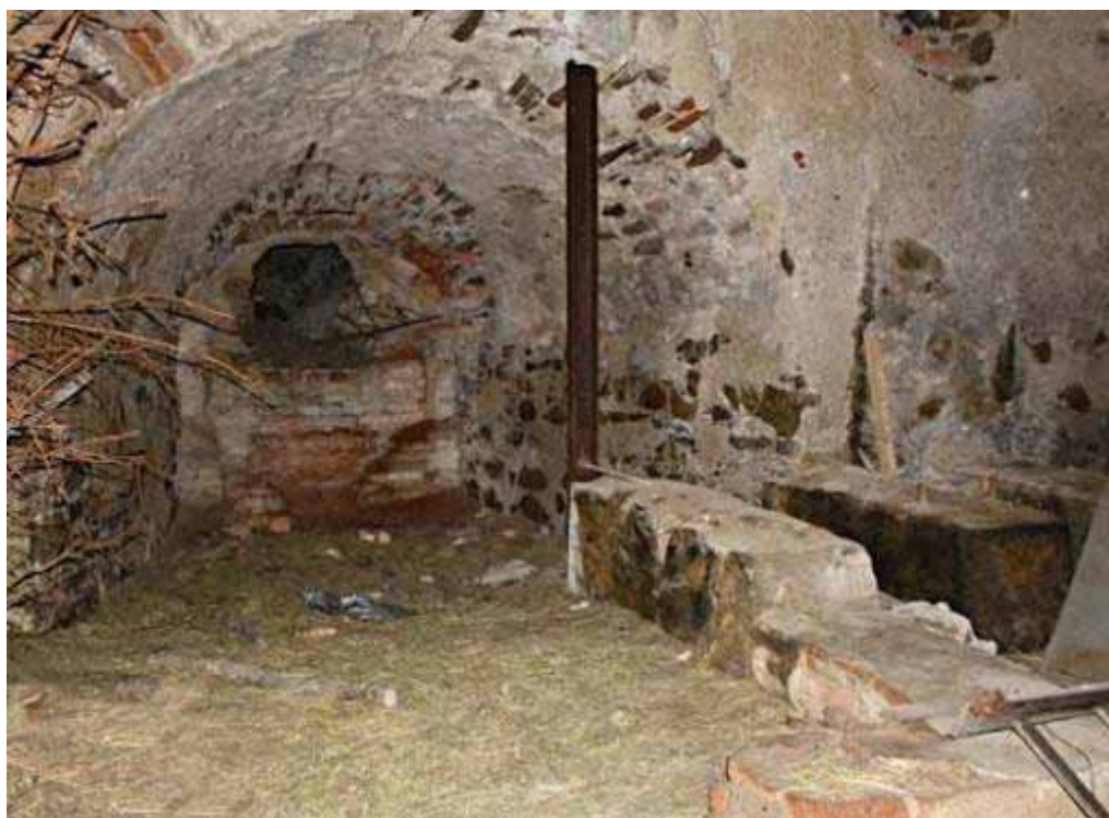
Obrázek 7.12. Pohled do suterénu budovy
