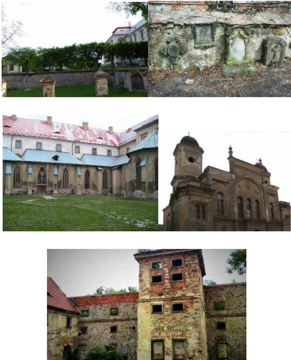
Obrázek 10.3.-7. Současný havarijní stav vybraných částí klášterního komplexu
