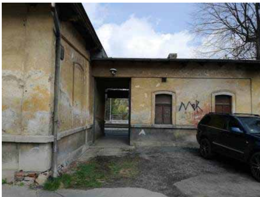
Obrázek 11.10. Staniční budova – pořízeno 2018
