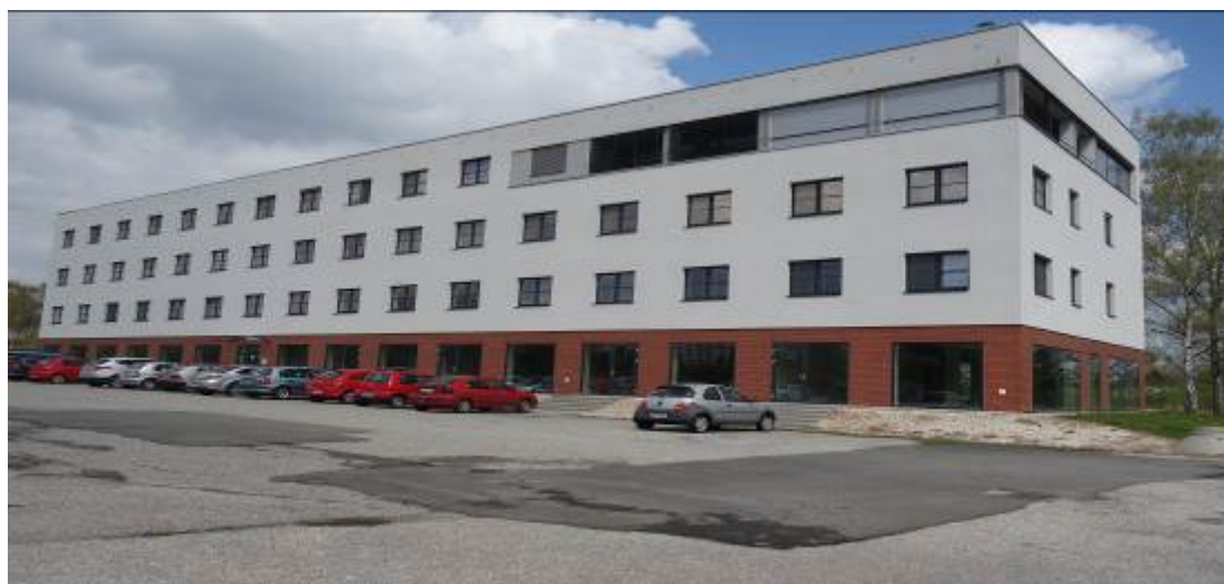
Obrázek 71 Rekonstruovaná budova bývalých kasáren 305. dělostřeleckého pluku
