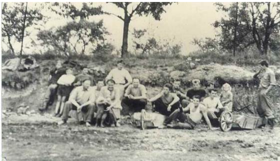
Obrázek 23 Výstavba starého fotbalového hřiště
