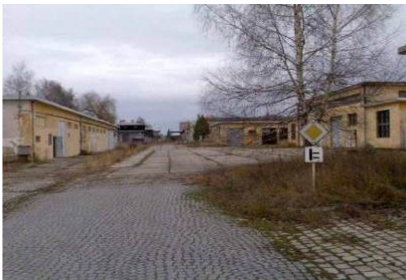
Obrázek 69 Vpravo dnes již neexistující budovy v prostoru kasáren Jana Žižky, jejichž demolice proběhla při úpravě části areálu v letech 2008- 2012
