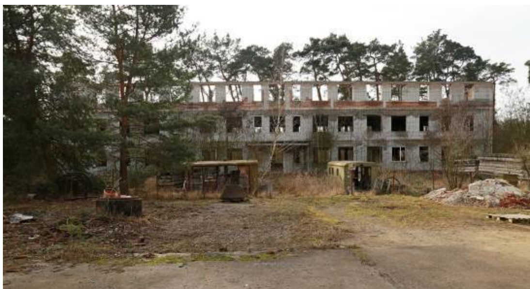
Obrázek 31 Nedostavěná budova polikliniky
