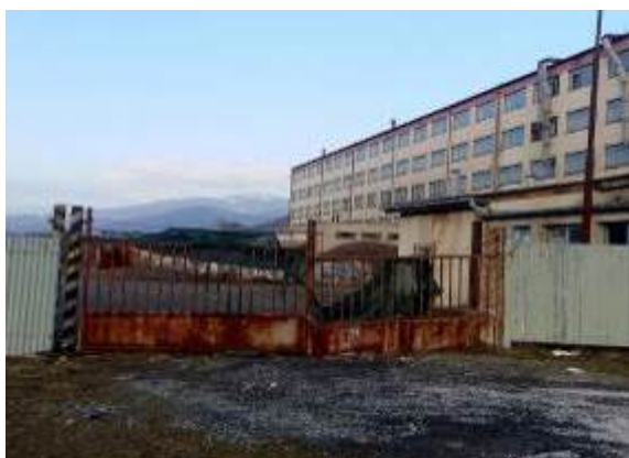
Obrázek 18 Současný stav budov
