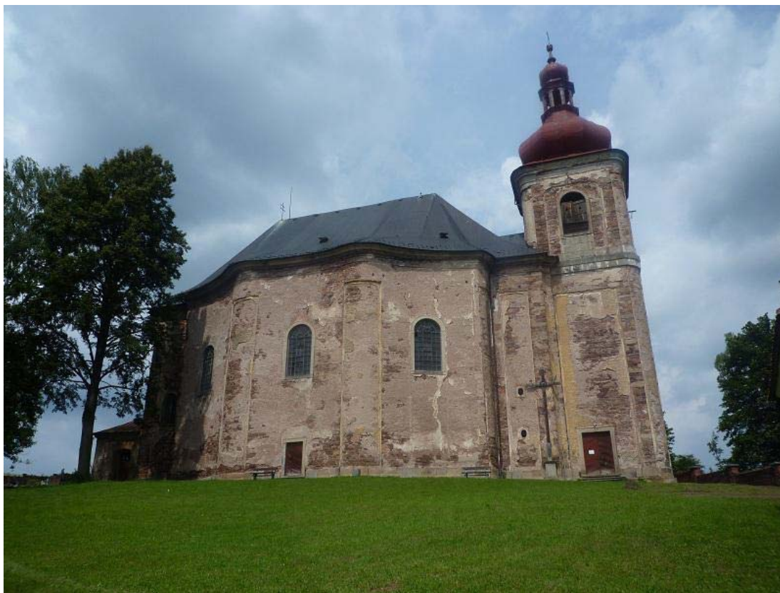
Obr. 15 Kostel Všetech svatých
