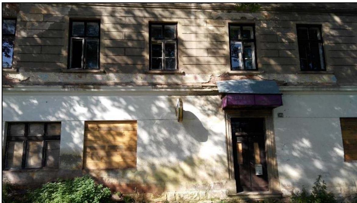
Obr. 18 Opuštěná budova (brownfield)
