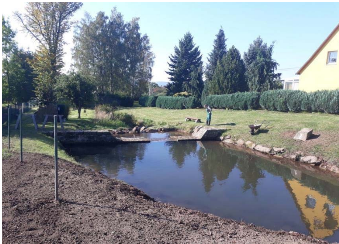
Obr. 41 Protipovodňová opatření – realizace
