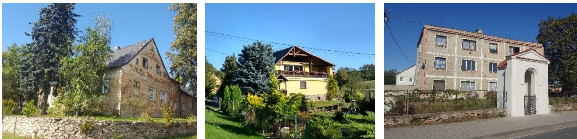
Obr. 42 Původní a nová zástavba
