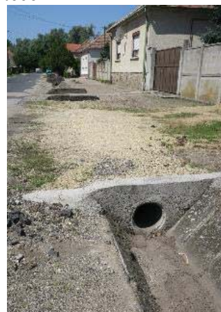
Obr. 60 propustek a příkopová tvarovka zaústěná do koryta vodoteče
