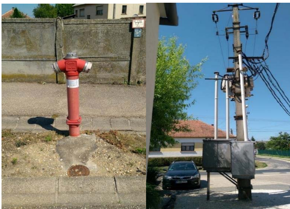
Obr. 89-90 Technická infrastruktura v obci v obnově
