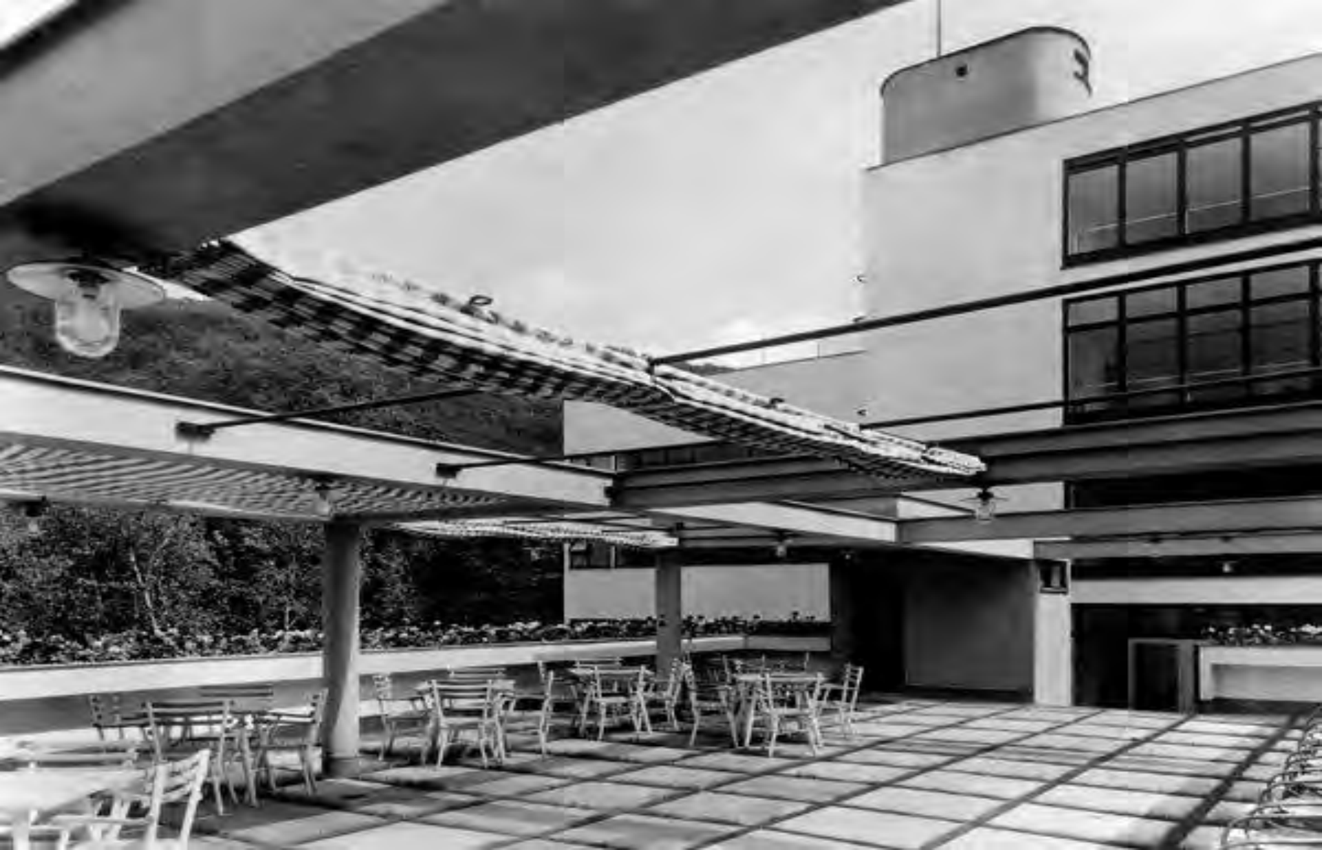
Strešná terasa nad spoločenskou časťou Foto: Zdroj: archív Spoločnosti Jaromíra Krejčara
