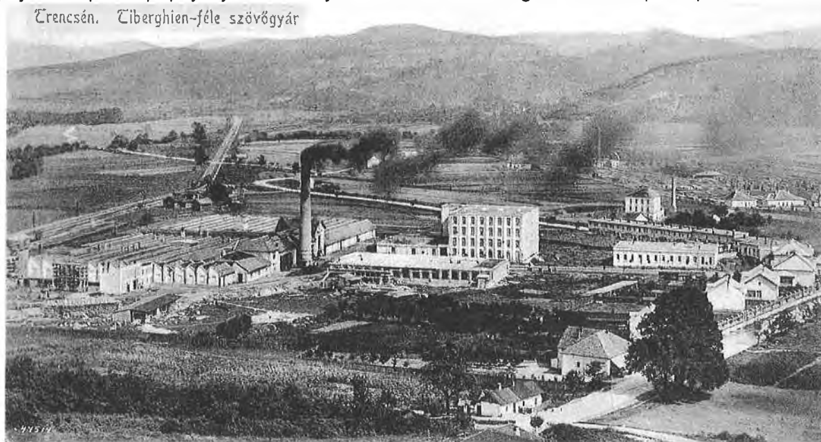
Elektrárň Tiberghien s dymiacim komínom, kotolňou, strojovňou a továrenskými budovami v okolí, medzi rokmi 1912 a 1915.
