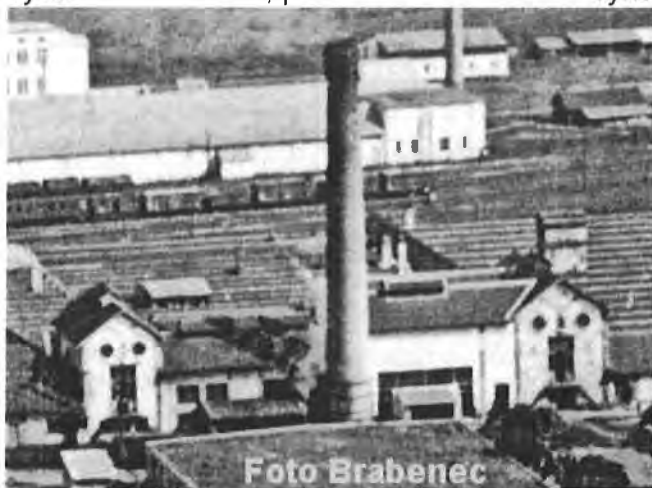
Elektrárň Tiberghien s komínom, kotolňou, dvomi strojovňami, v období 1922 - 1929. K prvej (severnejšej) strojovni (vpravo od komína) bola postavená druhá (južnejšia) strojovňa (vľavo od komína), ktorá na priečelí nesie rok postavenia 1922 (jestvuje doteraz).
